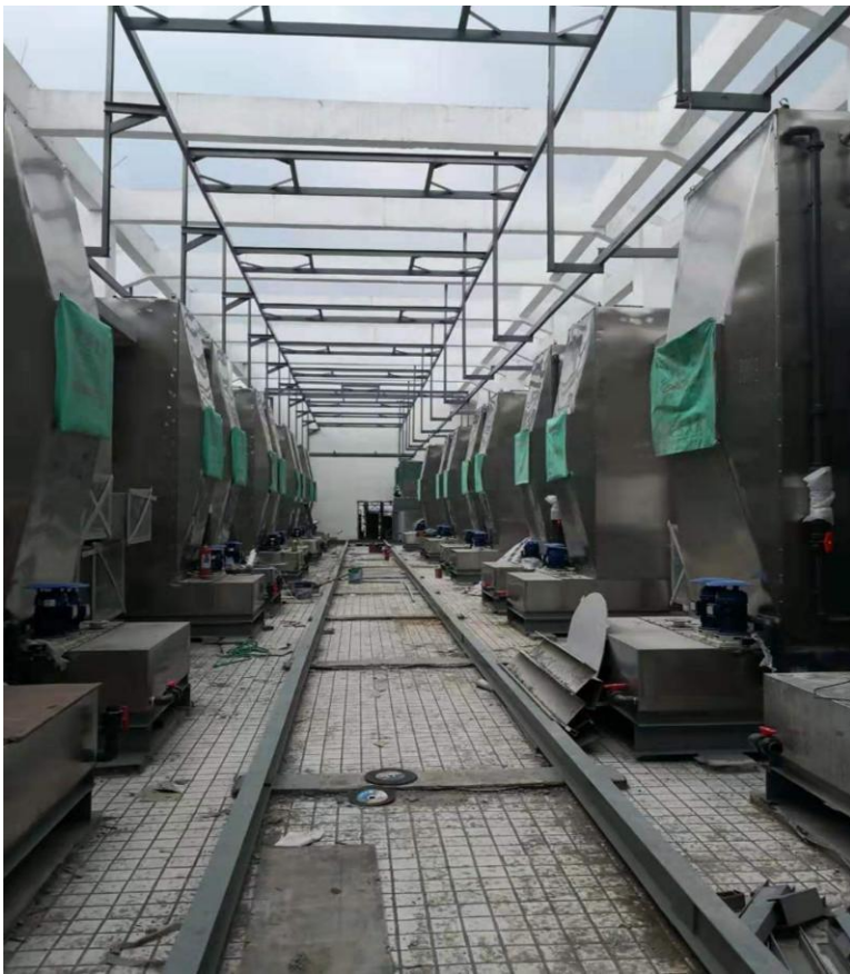
浙大项目的楼顶设备层
