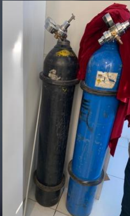
氮气钢瓶、氧气钢瓶均未固定
