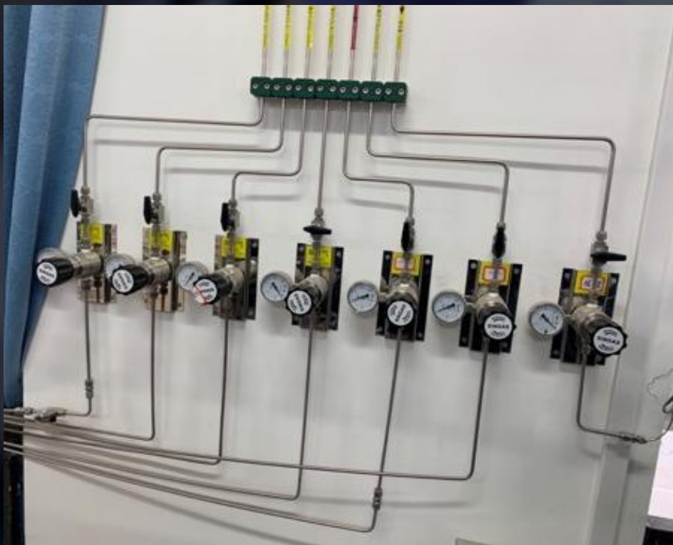
气路管道上的气体种类标识错误
