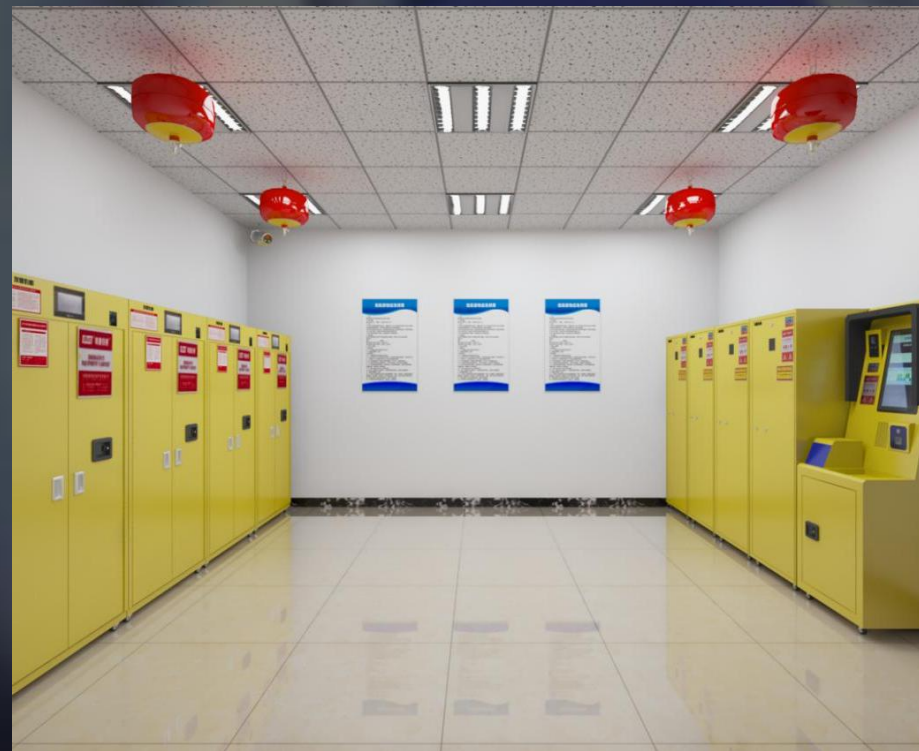
易制毒危险化学品储存库
