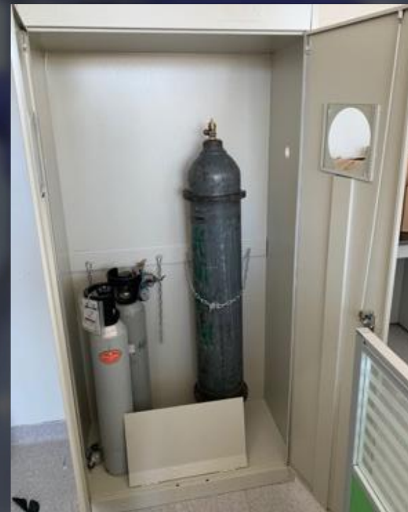
氨气瓶没有全部采用气瓶柜上的链子固定
