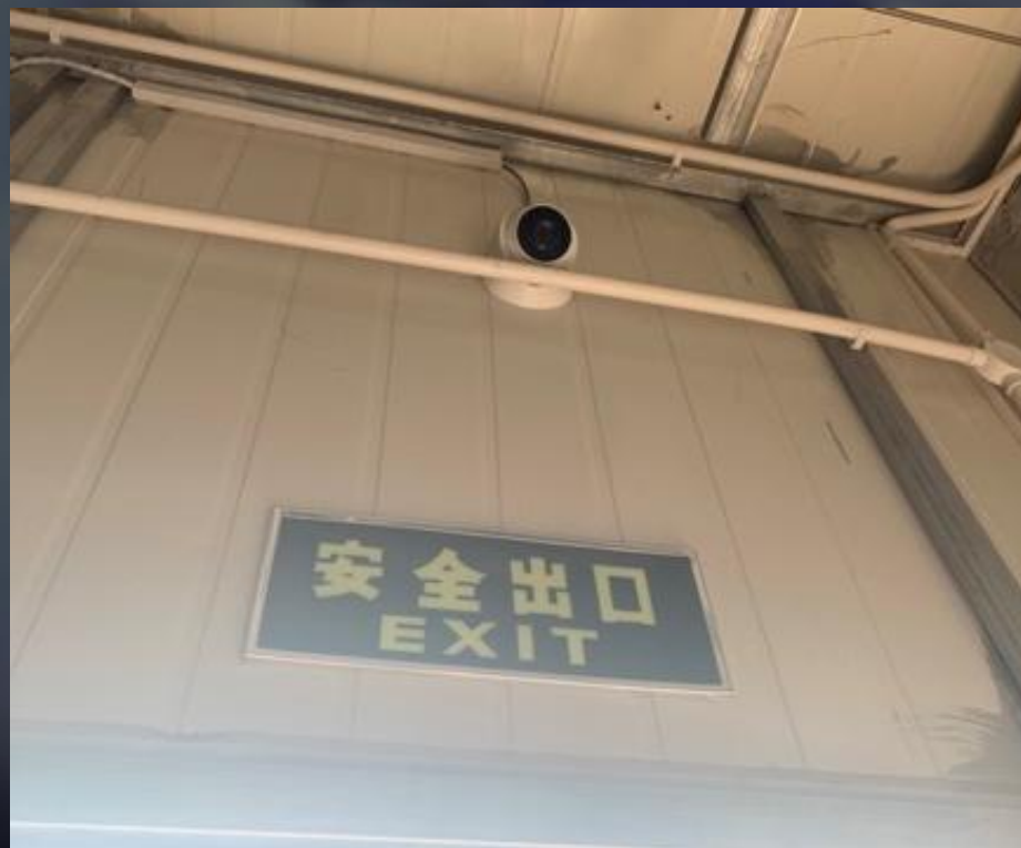
气瓶间未做整体防爆（线路未用防爆套管、监控未采用防爆型摄像头、安全出口指示牌极不规范）
