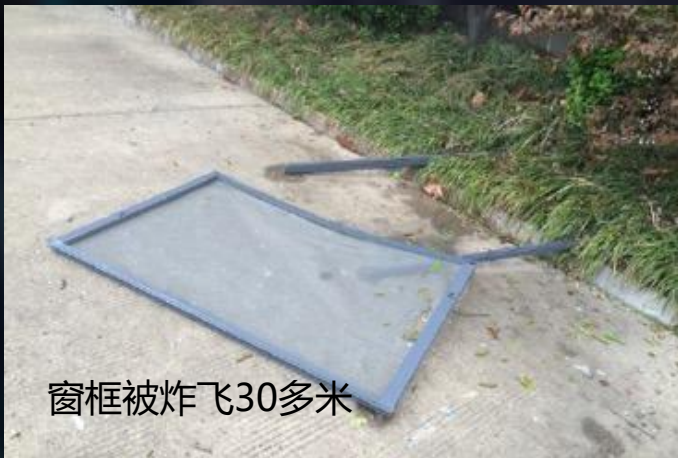
实验楼爆炸现场
