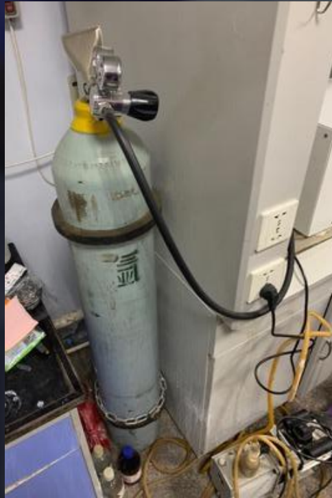
氮气钢瓶固定部位不对（不稳）
