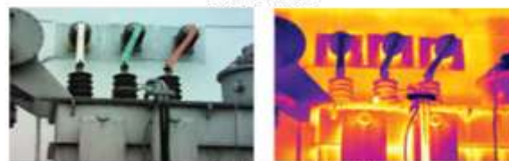
变电站10kV所用变
